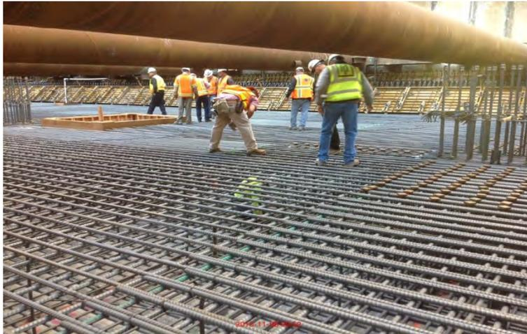
Rebar inspection prior to concrete pour
